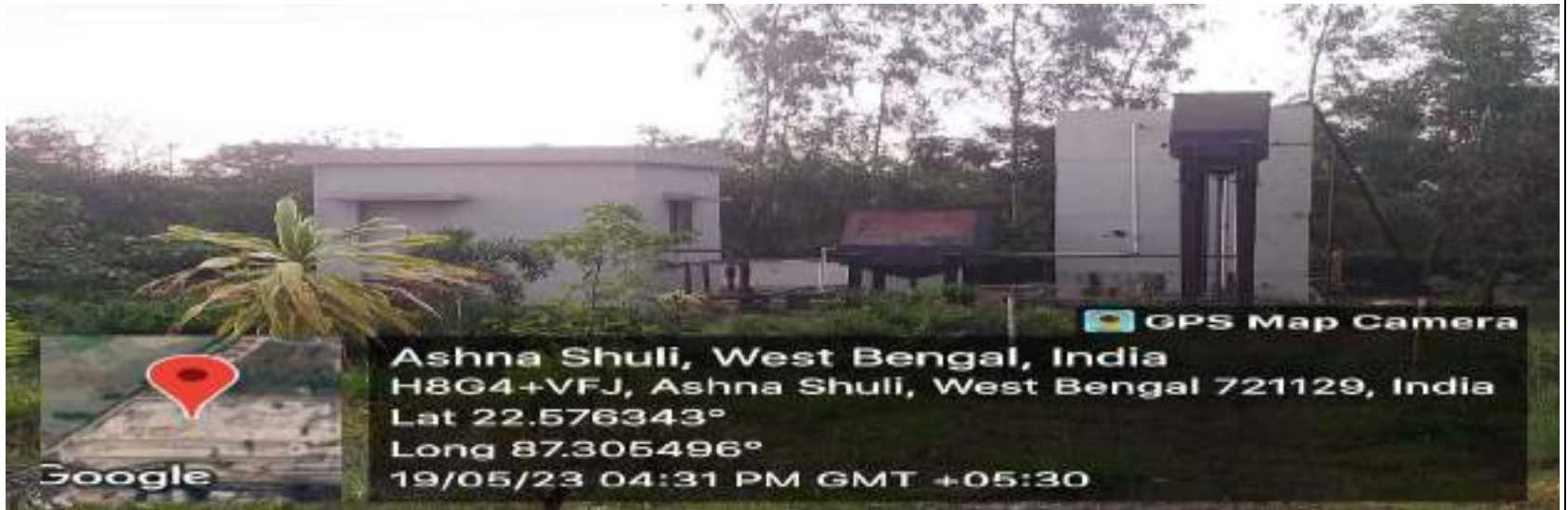
STP 60 KLD(Photograph - XIV)
