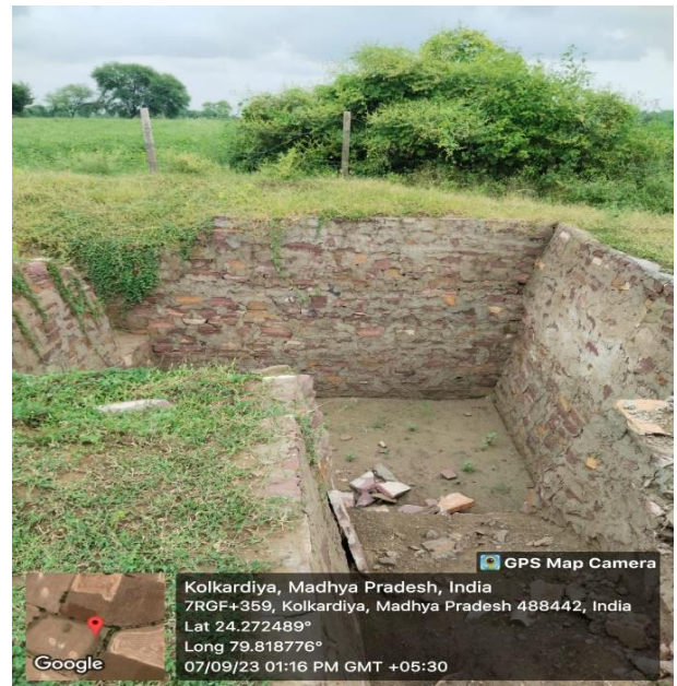
Siltation Pit -2 (L&W 5.5 and Depth 2.8)
