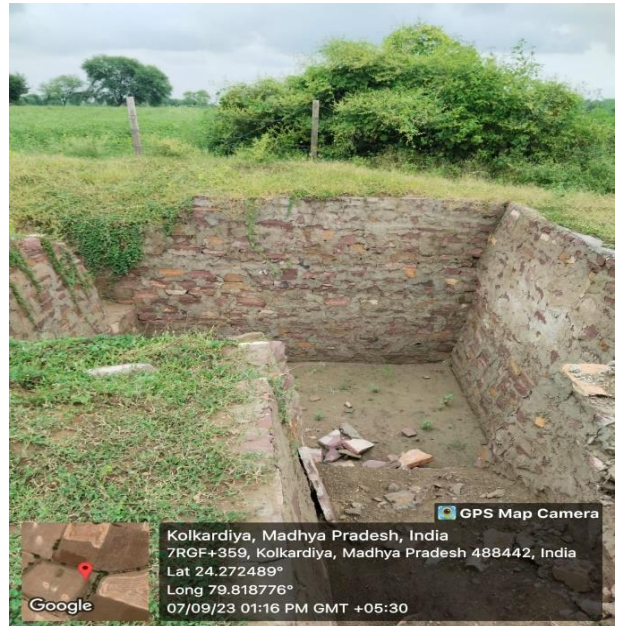
Siltation Pit -2 (L&W 5.5 and Depth 2.8)
